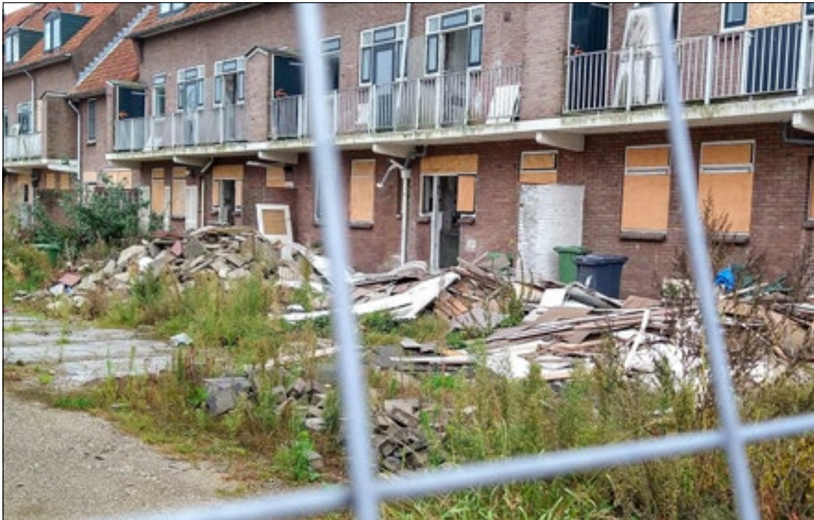
Op de plek van de gesloopte woonwijk moeten 184 nieuwe huurwoningen komen. (foto: Marinus van Heiningen)
