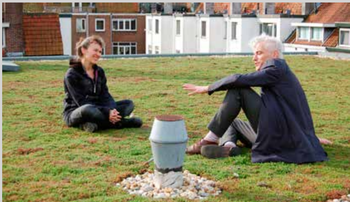
Een groen dak scheelt 's zomers in de hitte en 's winters isoleert het. Dat zie je terug in de energierekening.
