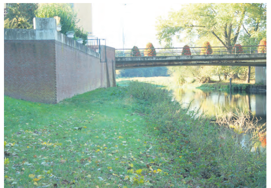
Doorkijk onder Niersbrug. Aan de linkerkant is de vlonder gepland. (archieffoto: Jos Gröniger)
